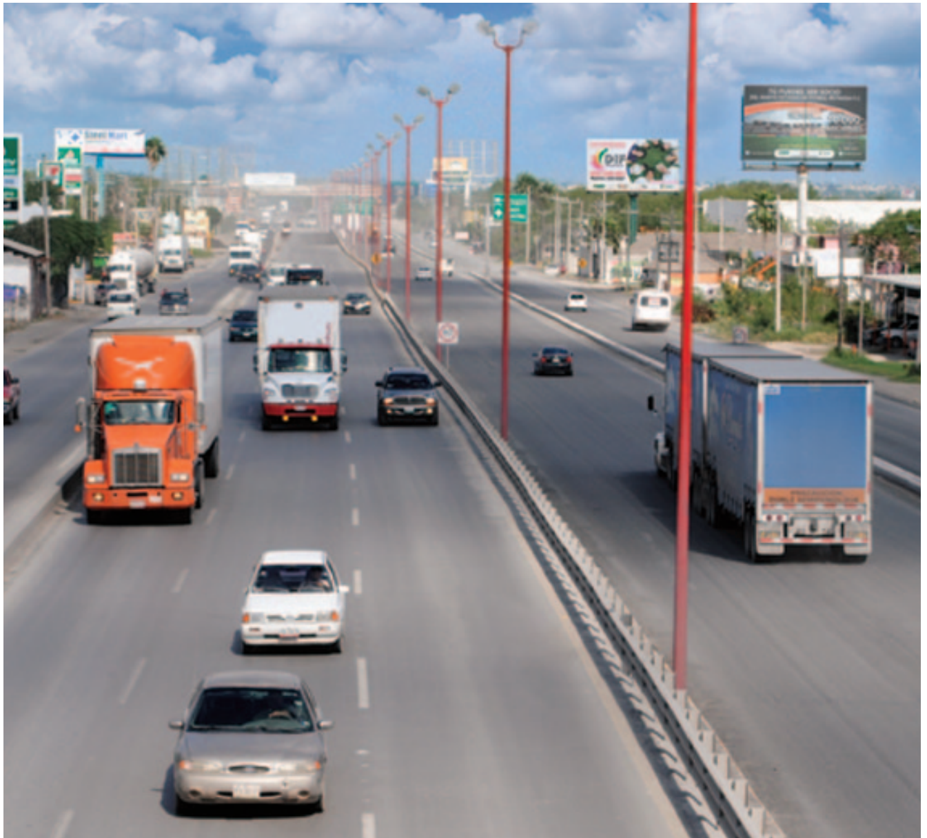
Ampliación del libramiento Reynosa - Río bravo a 10 carriles que otorgan más seguridad y comodidad
