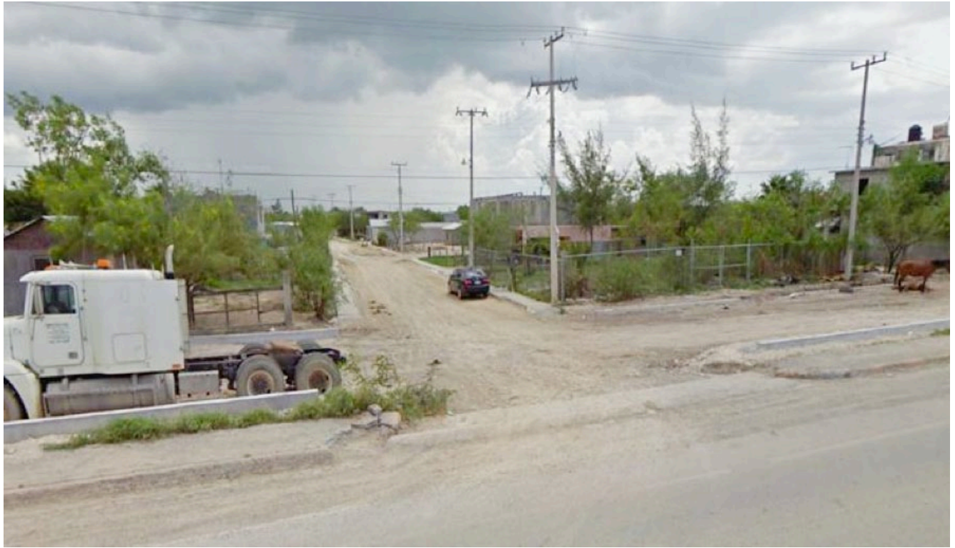
Ilustración 16. Pavimento sin terminar y Ausencia de luminarias, que contribuye a la percepción de la sensación de inseguridad.
